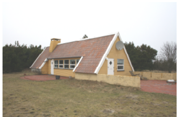
Det eksisterende sommerhus er opført i 50'erne.
